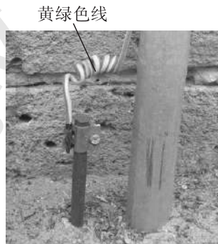
图 1-12 接地装置
