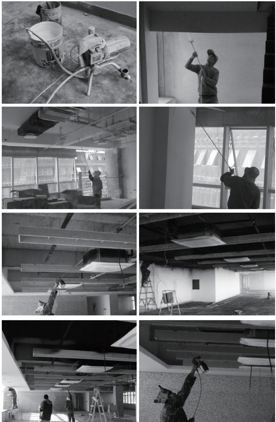
图 2-6 天棚弹涂施工现场图录 /2013
