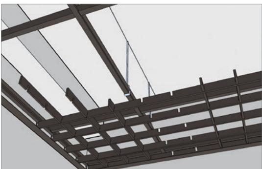
格栅主副骨组装：将格栅的主副骨在下面按设计图纸的要求预装好。
