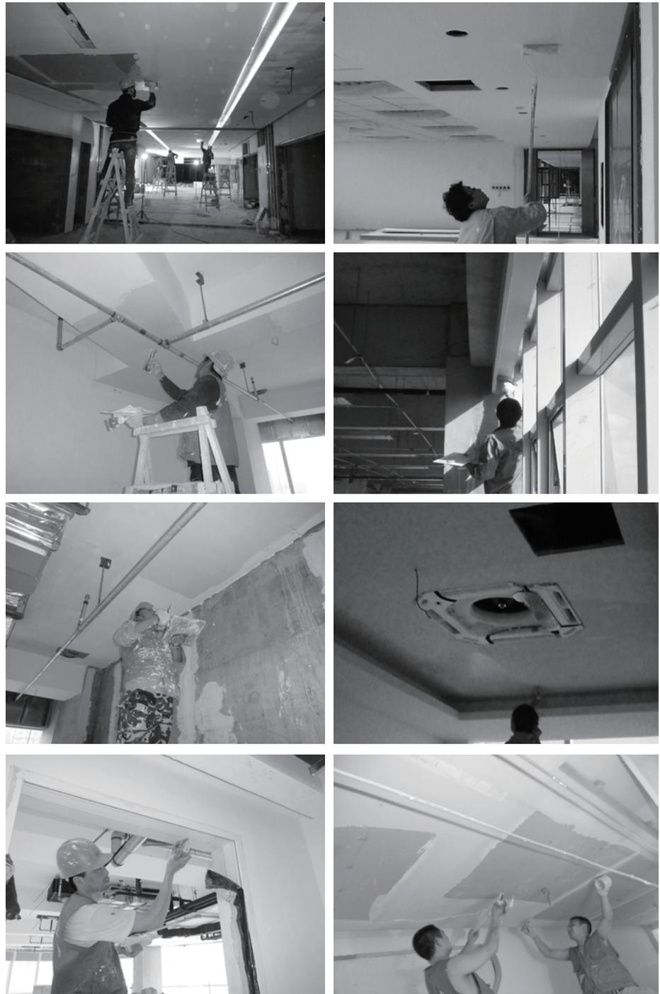
图 2-7 天棚大白乳胶漆施工现场图录 /2013
