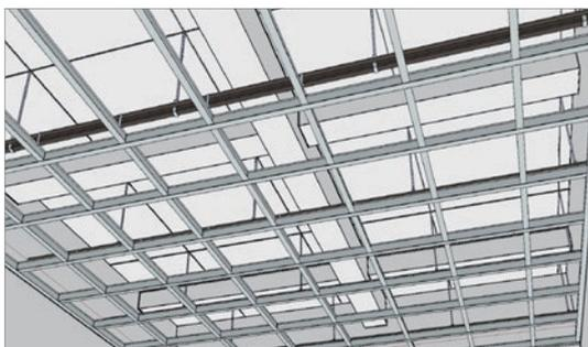
安装次龙骨：配套次龙骨选用烤漆 T 形龙骨，间距与板横向规格相同，将次龙骨通过挂件吊挂在主龙骨上。
