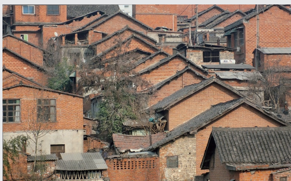
图 1-24 砖混结构的低层建筑 / 秦楚网 / 中国 / 2013
