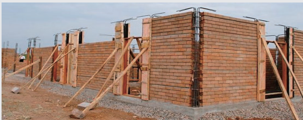
图 1-23 砖混结构住宅开间和进深小 / 嘉龙劳务 / 中国 / 2014
