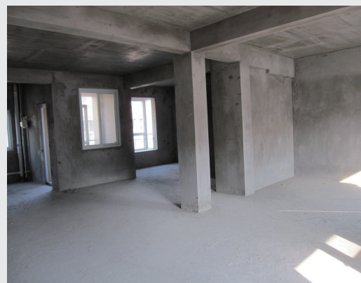
图 1-30 框架结构改造起来较简单 / 城际分类网 / 中国 / 2014
