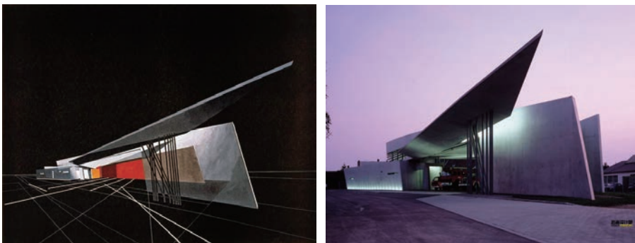
图 3-9 德国莱茵河畔魏尔镇消防站 / 扎哈·哈迪德
